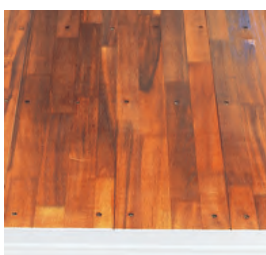
床板(アカシア集成材) 環境に配慮し、植林木を100%利用。
