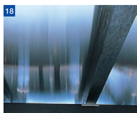
アンダーシート(アルミ張り)
