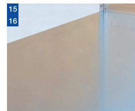
床張り(亜鉛鋼板張り)
