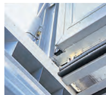
センタービームの断熱・気密構造
