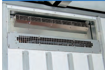
縦型エアリブ (エバコン一体型冷凍機取付時)
