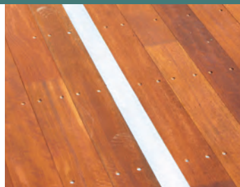
井桁構造床面 縦根太が床面に露出するタイプとなりますので ご承知ください。
