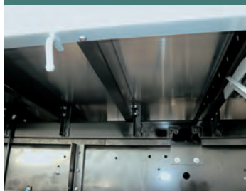
床アンダーシート(アルミ全面張り) 床下からの水上がりを防ぎます。
