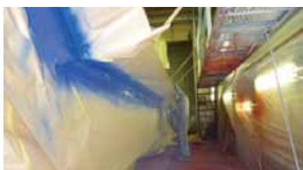
改善後は1回のマスキングで多色塗装ができるようになり、作業時間も使用エネルギーも大幅に削減できています。
