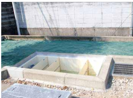
構内従業員駐車場付近に降る雨水の敷地外放流口手前に油水分離槽を設置し、雨水の水質管理をできるようにしました。
