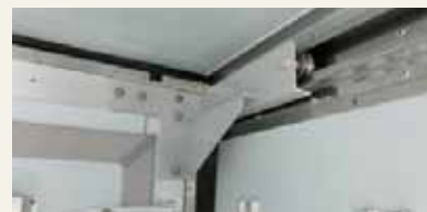
移動間仕切りはレールに沿って前後に移動が可能
