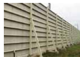
敷地西側の防音壁
